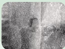
Une encoche pour recevoir une barre de fermeture
