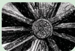
La voûte d'ogive et sa clé de voûte sculptée
