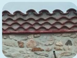
Génoise (fermeture d'avant-toit) > Dans tout le village
