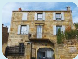
Maison de maître > Rue des Perreux
