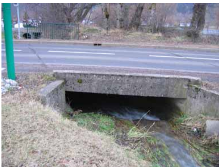
Photo 9 : ouvrage sous-dimensionné au lieu dit Varennes (en relation avec une sursédimentation (point 2) (photo BCEOM)
