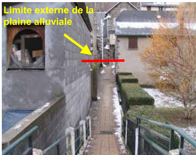
Photo 10 : limites physiques hydrogéomorphologiques dans le village (photo BCEOM)
